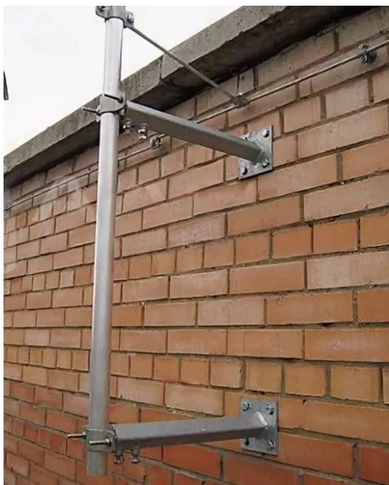
Рисунок 21 – Пример крепления мачты
